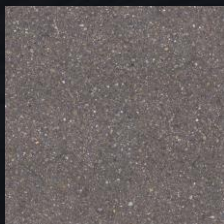
Ubicación: Estacionamiento PAVIMENTO ASFALTICA
