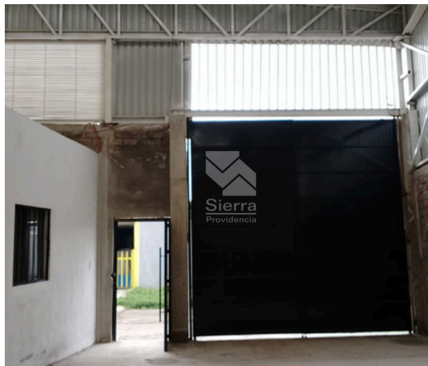
INGRESO A BODEGA
