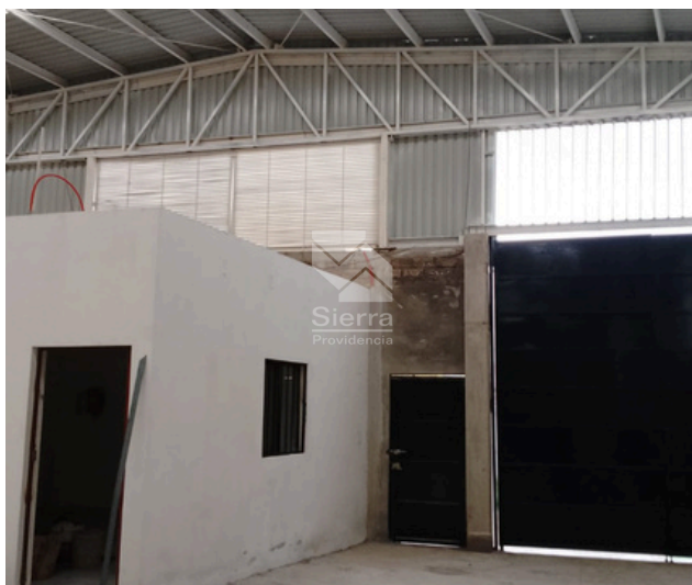
INGRESO A BODEGA
