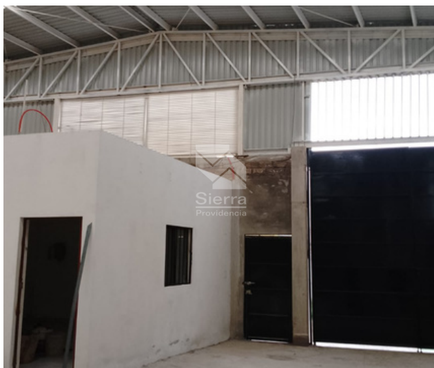
INGRESO A BODEGA
