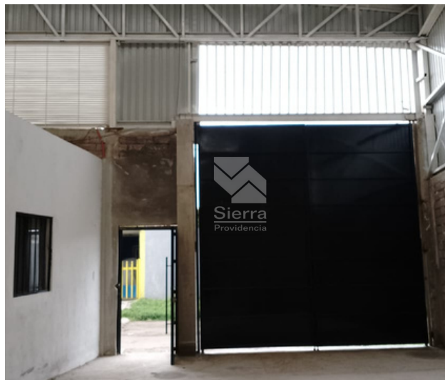
INGRESO A BODEGA
