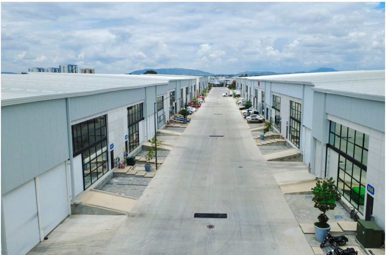
VIALIDAD BODEGAS CAPITAL PARK
