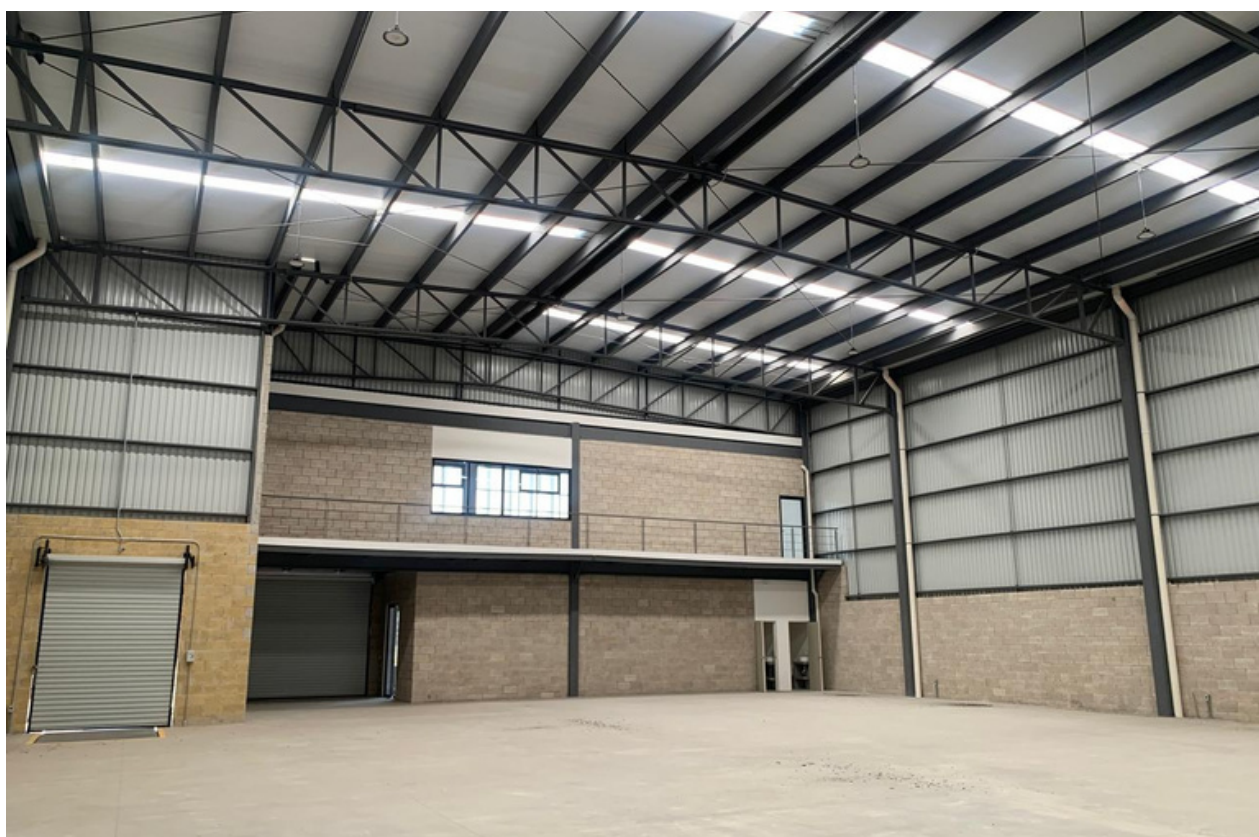
Interior bodega planta baja
