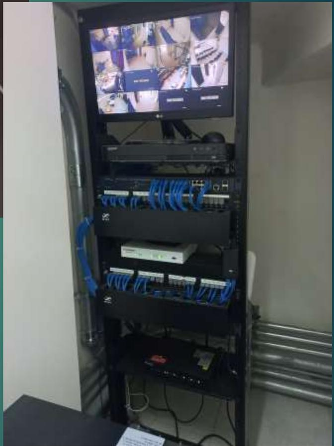
Site Voz y Datos con respaldo de energía, y CCTV con 13 cámaras
