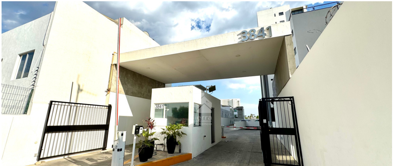
ENTRADA A CONDOMINIO
