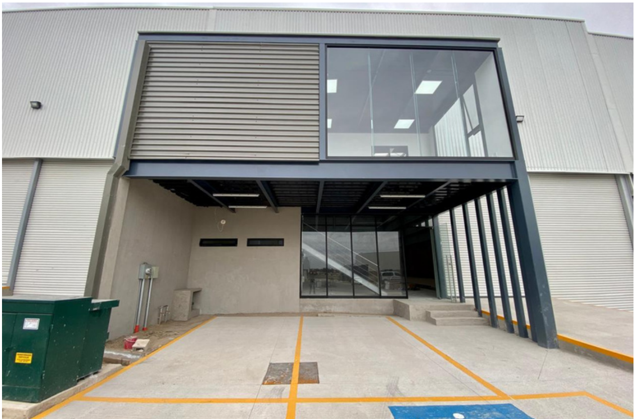
FACHADA DE BODEGA
