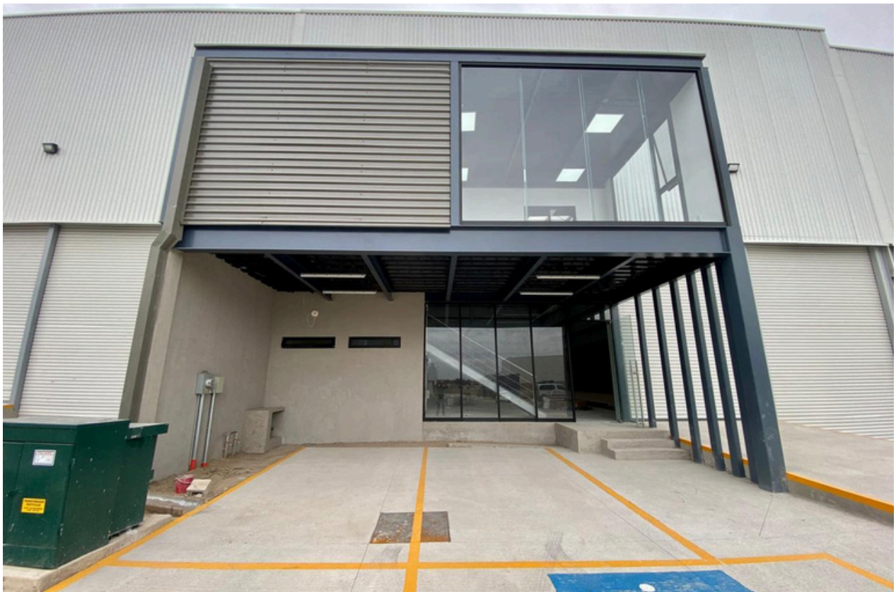
FACHADA DE BODEGA
