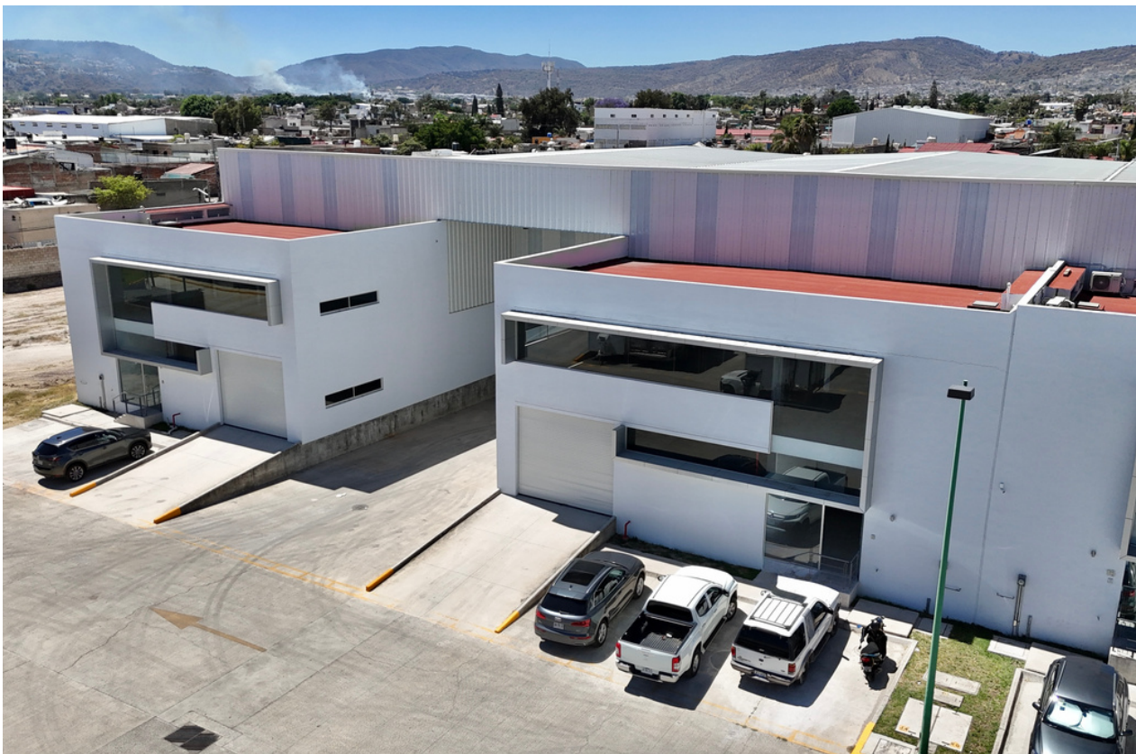
FACHADA DE BODEGA
