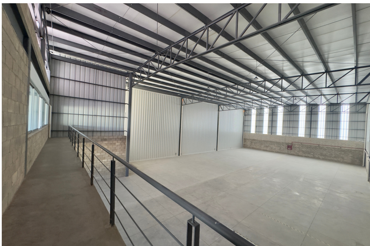
VISTA DE ALMACEN DESDE SEGUNDO PISO
