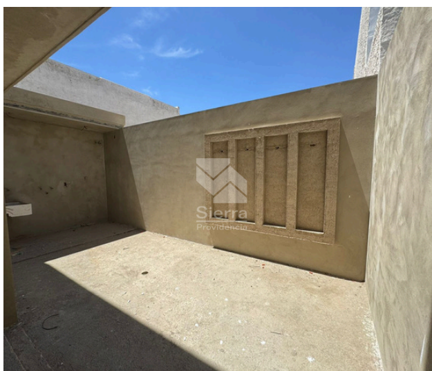
AVANCE DE OBRA
