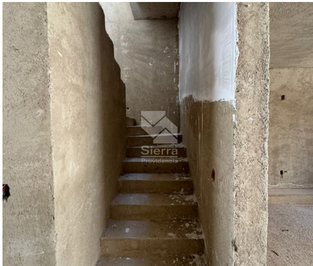
AVANCE DE OBRA
