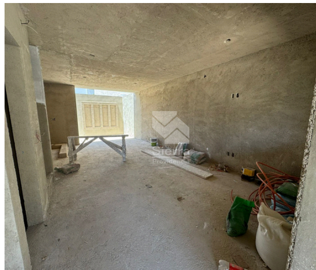
AVANCE DE OBRA
