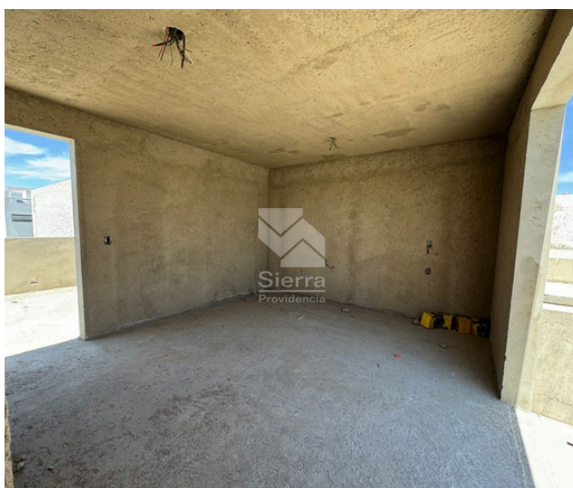
AVANCE DE OBRA
