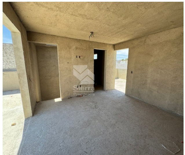
AVANCE DE OBRA
