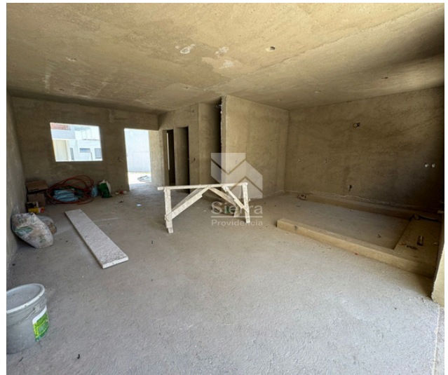
AVANCE DE OBRA
