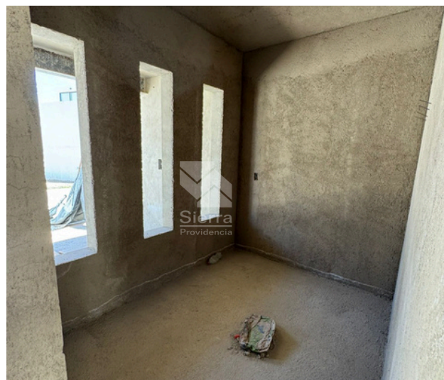
AVANCE DE OBRA
