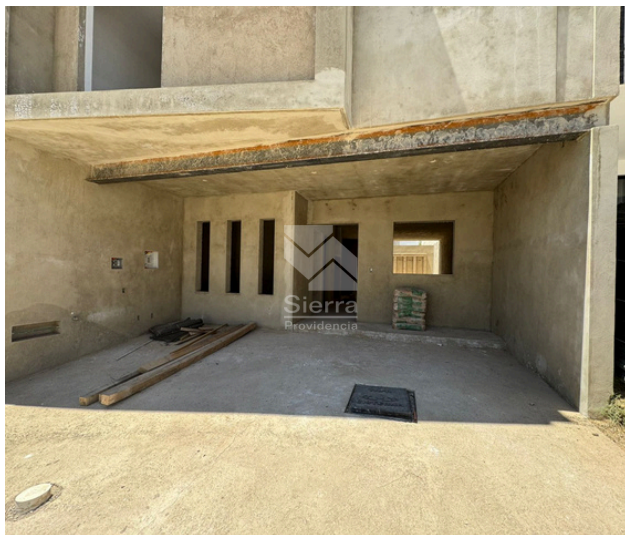
AVANCE DE OBRA
