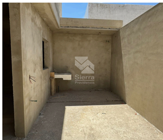
AVANCE DE OBRA
