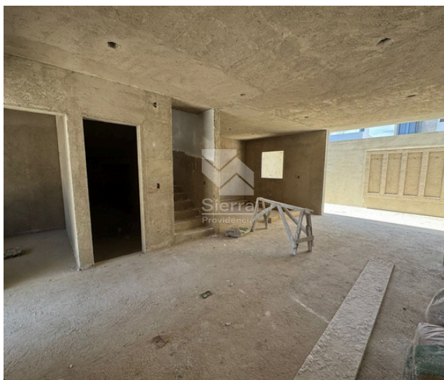
AVANCE DE OBRA
