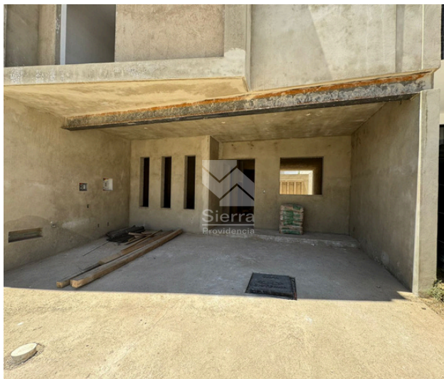
AVANCE DE OBRA
