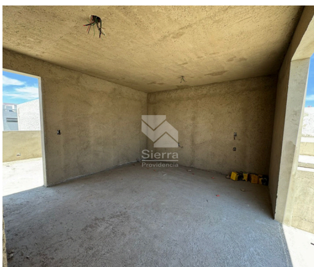
AVANCE DE OBRA
