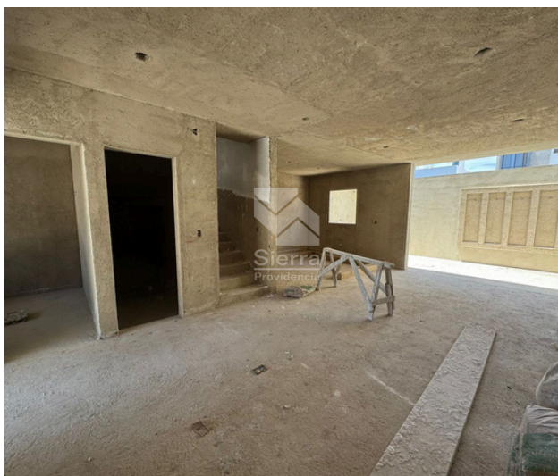
AVANCE DE OBRA
