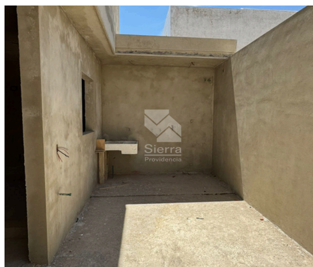
AVANCE DE OBRA
