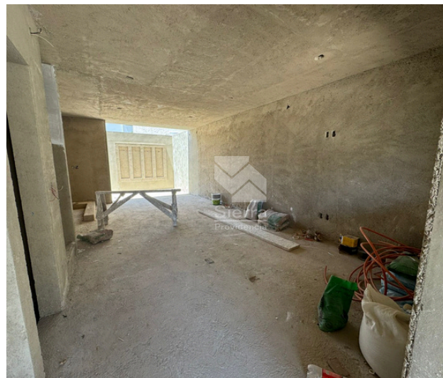
AVANCE DE OBRA
