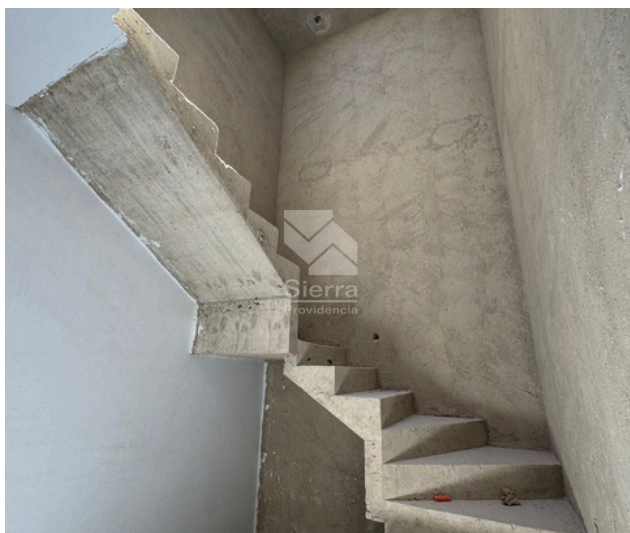
AVANCE DE OBRA
