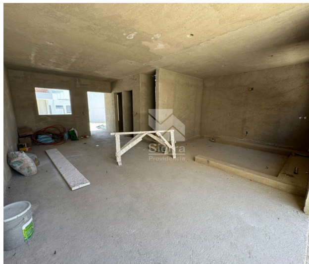
AVANCE DE OBRA
