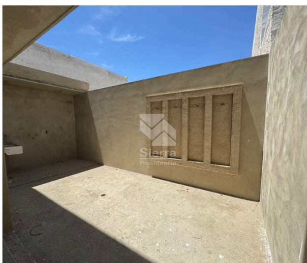
AVANCE DE OBRA
