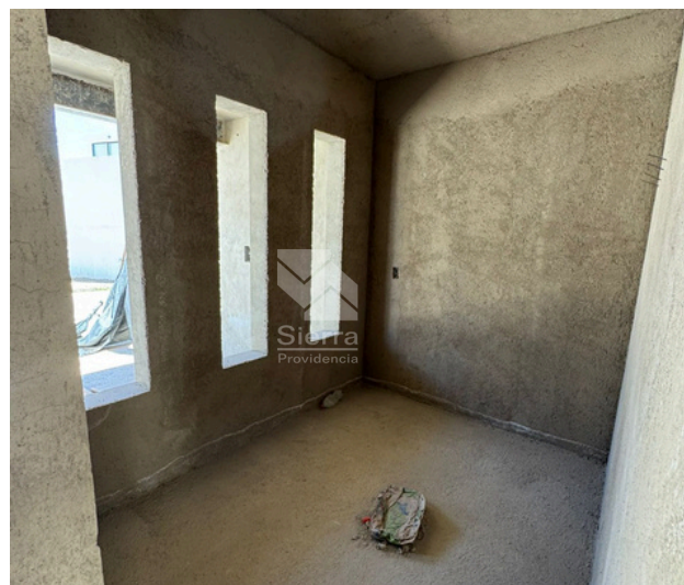
AVANCE DE OBRA
