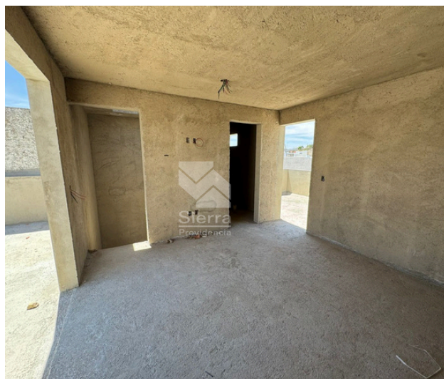
AVANCE DE OBRA
