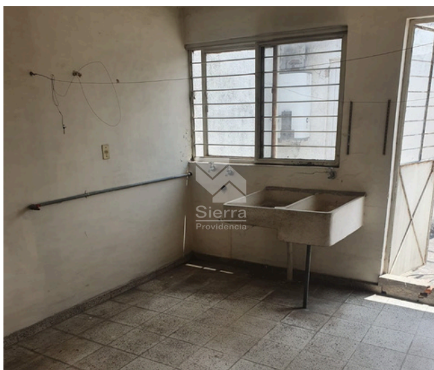
CUARTO DE LAVADO
