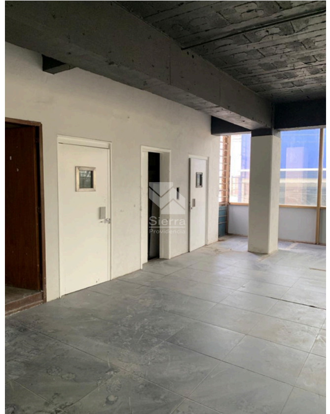
ÁREA DE OFICINAS SEGUNDO NIVEL
