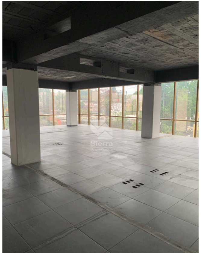
ÁREA DE OFICINAS PRIMER NIVEL
