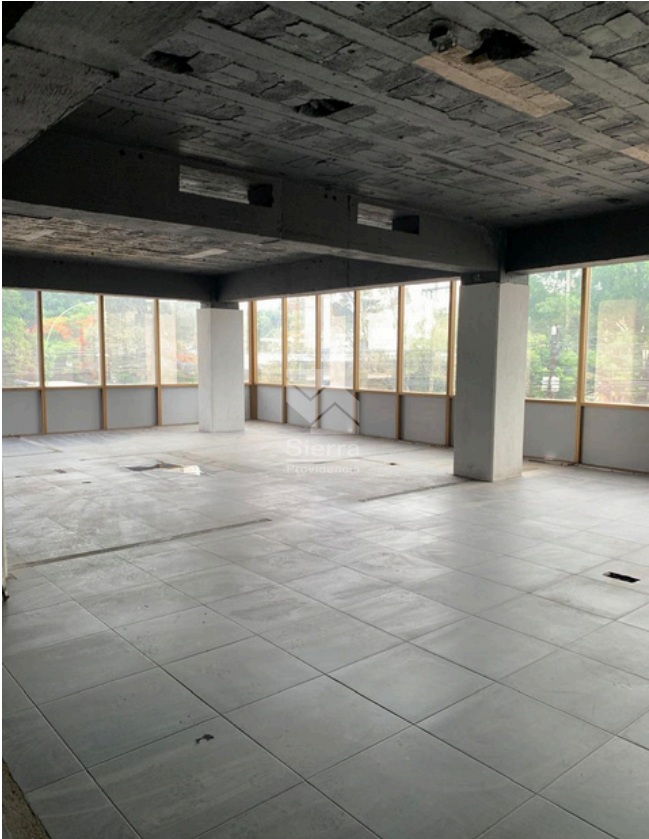
ÁREA DE OFICINAS SEGUNDO NIVEL
