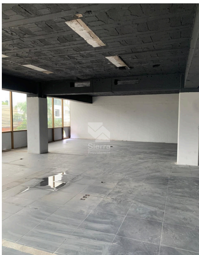
ÁREA DE OFICINAS PRIMER NIVEL
