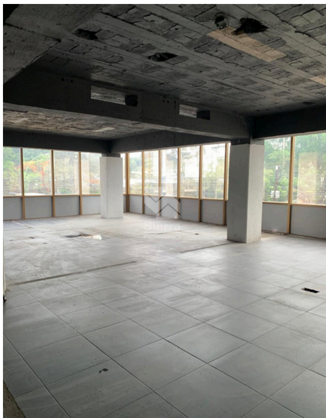
ÁREA DE OFICINAS SEGUNDO NIVEL
