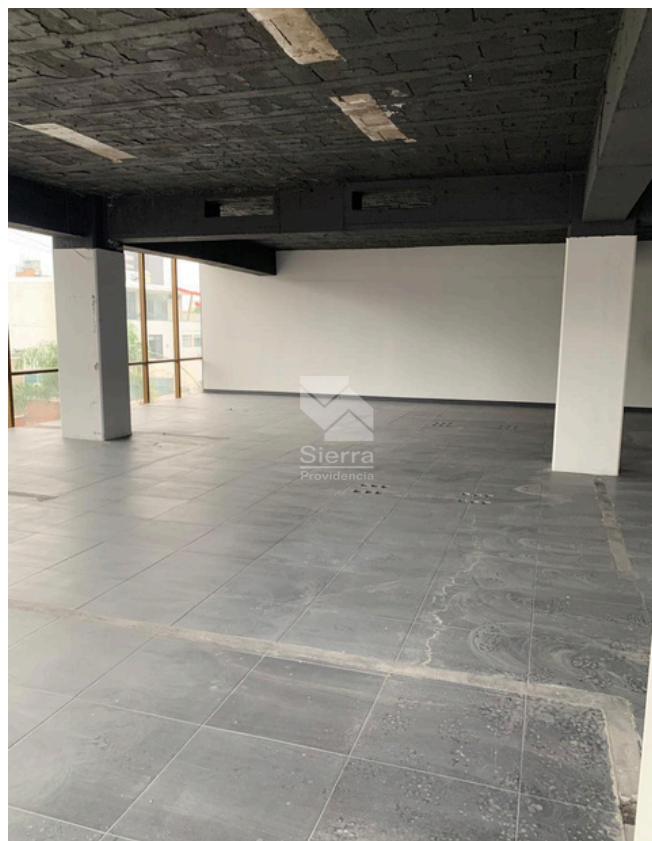
ÁREA DE OFICINAS PRIMER NIVEL
