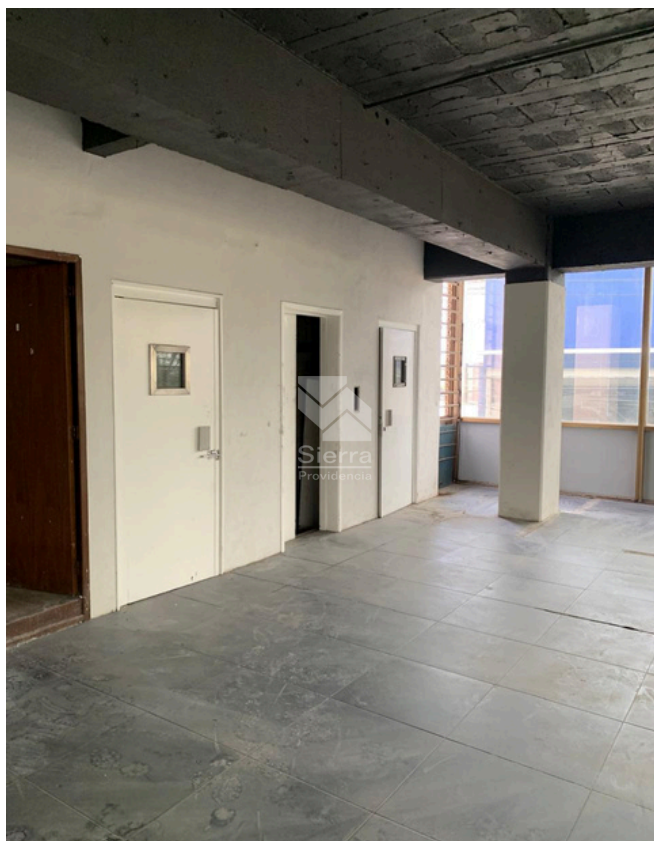
ÁREA DE OFICINAS SEGUNDO NIVEL
