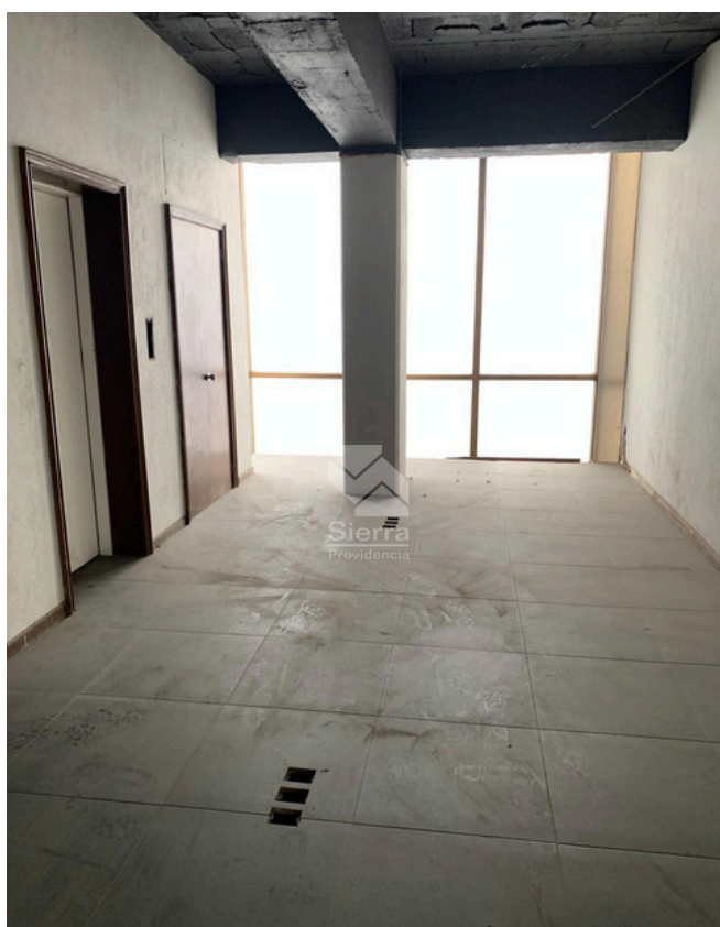
ÁREA DE OFICINAS TERCER NIVEL
