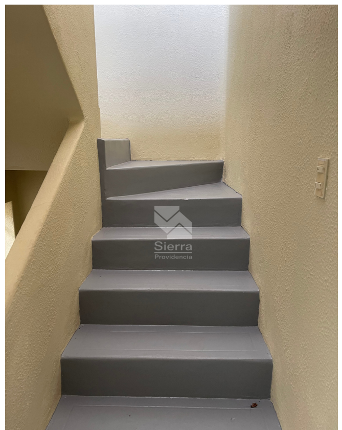
ESCALERAS DE SERVICIO
