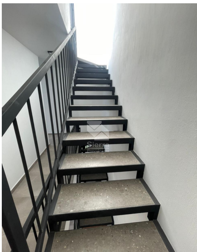
ESCALERAS A TERCER NIVEL
