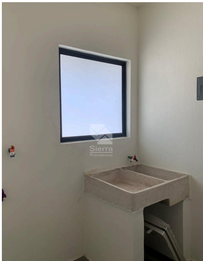
CUARTO DE LAVADO
