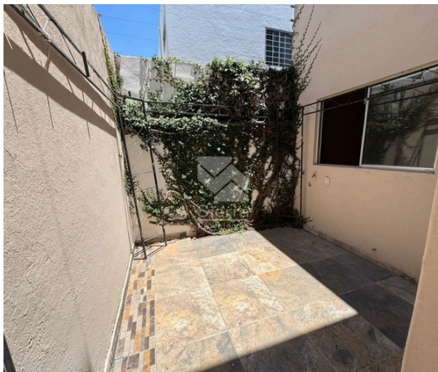
PATIO DE LAVADO
