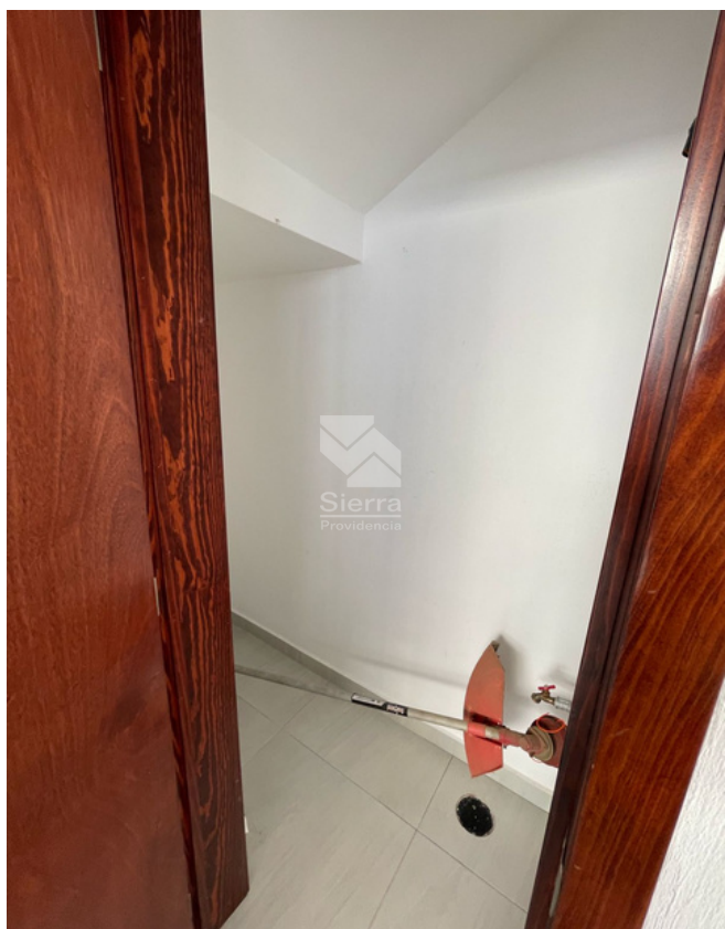
Bodega de bajo de escaleras
