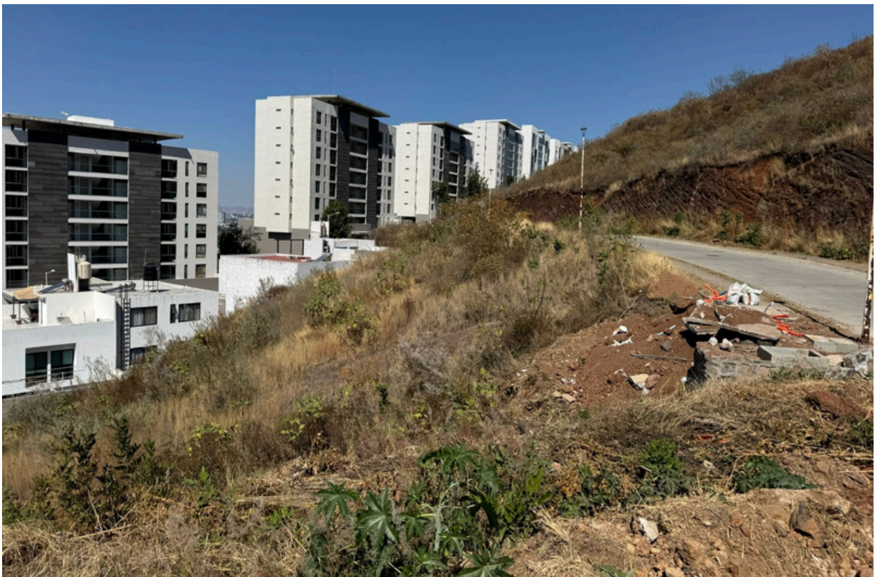
TERRENO VISTA VIALIDAD
