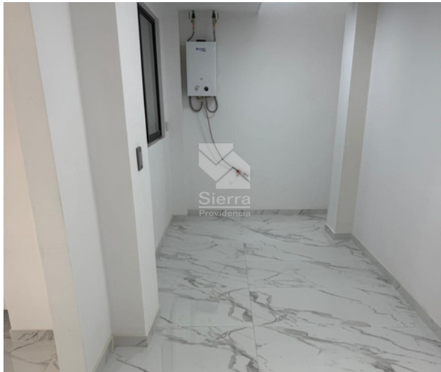
Cuarto de lavado
