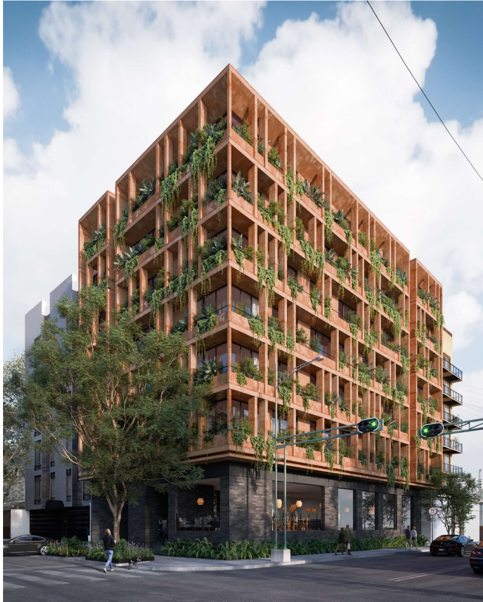
Vista desde esquina de Bajío y Medellín
