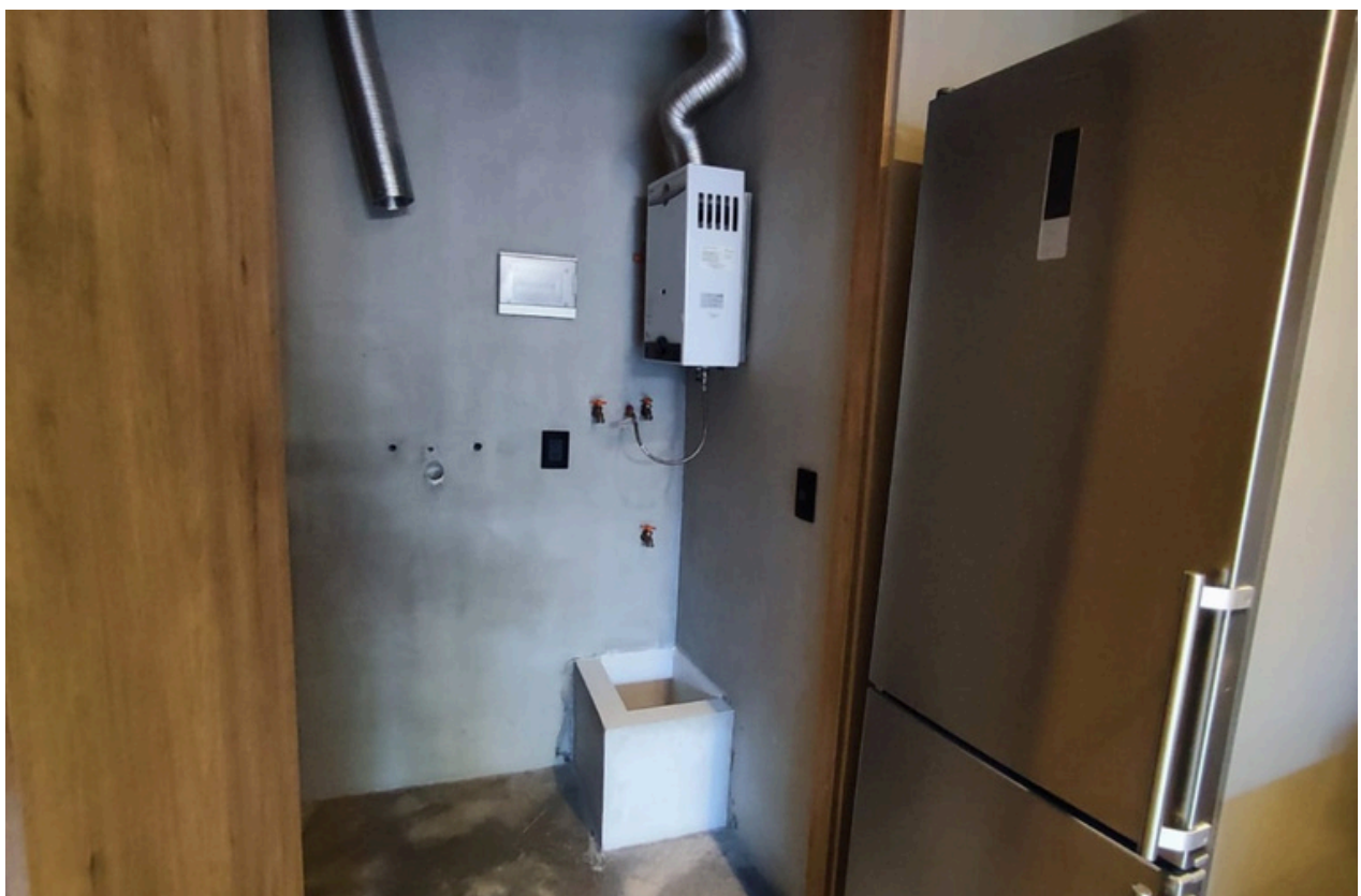
Cuarto de lavado
