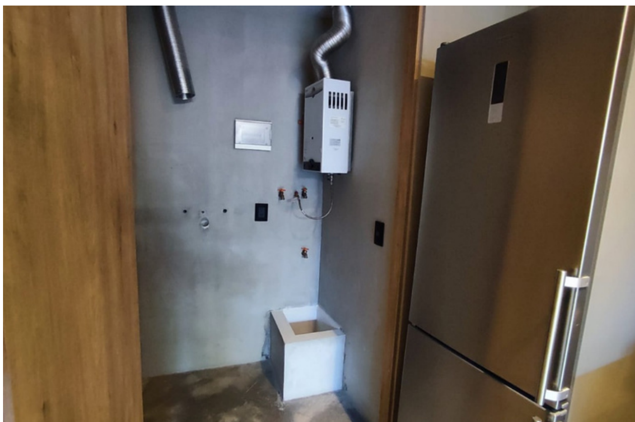
Cuarto de lavado
