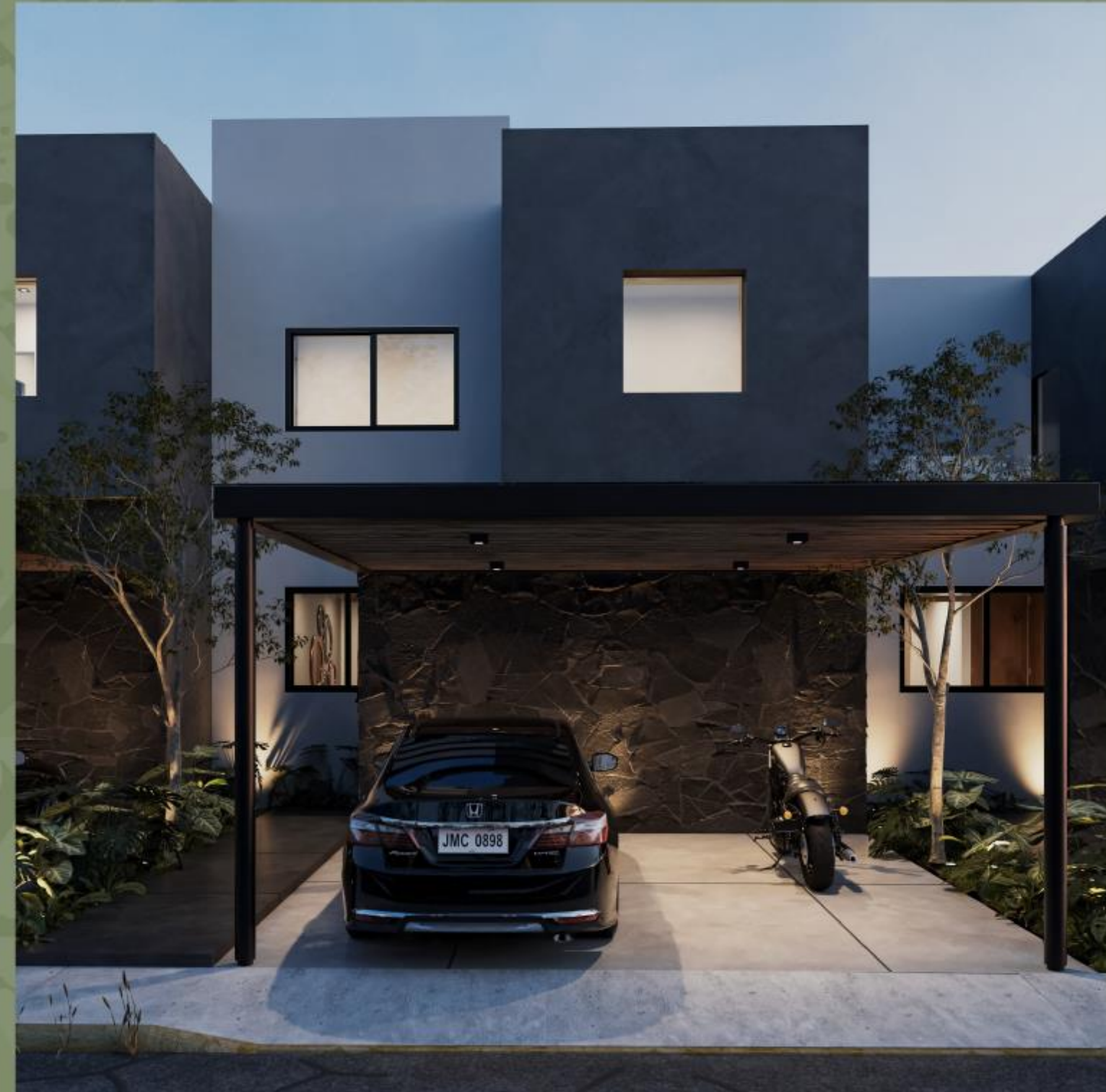
Fachada frontal de noche
