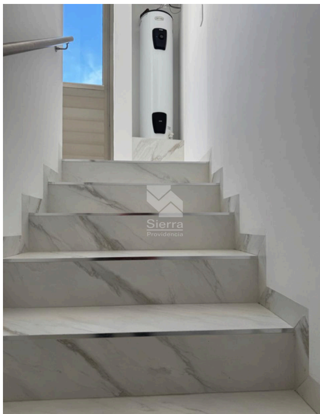
Escaleras tercer nivel
