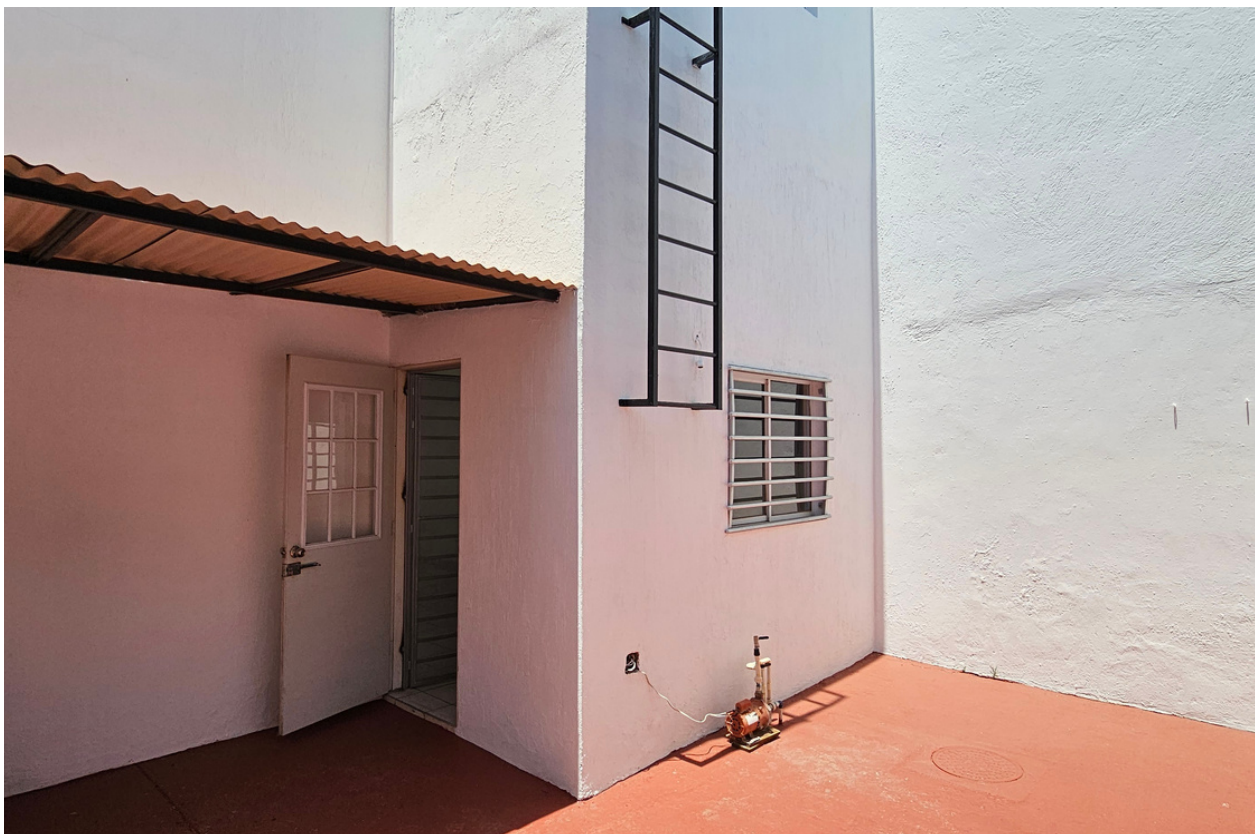
Patio / Área de lavado
