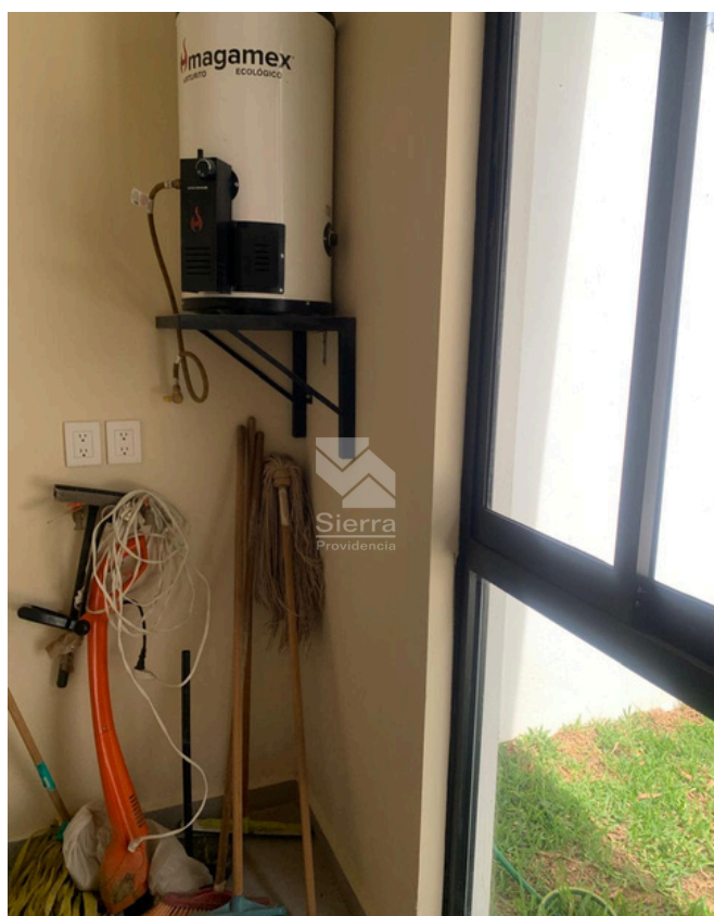
Patio de lavado
