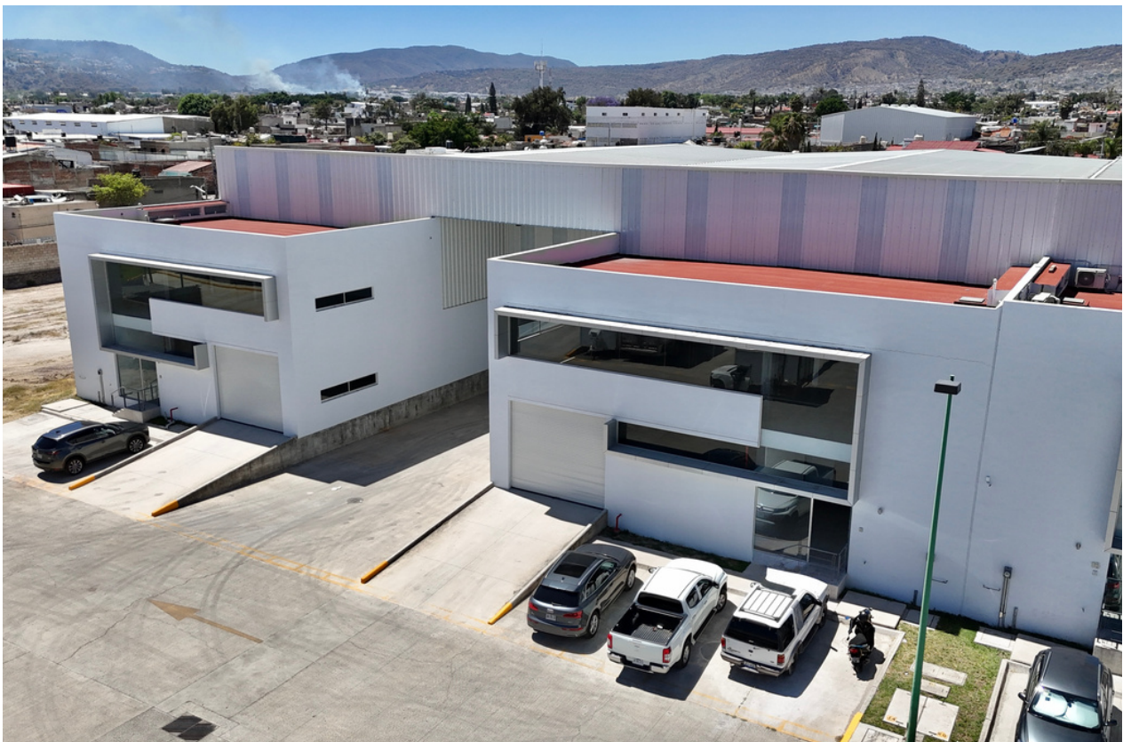
FACHADA DE BODEGAS
