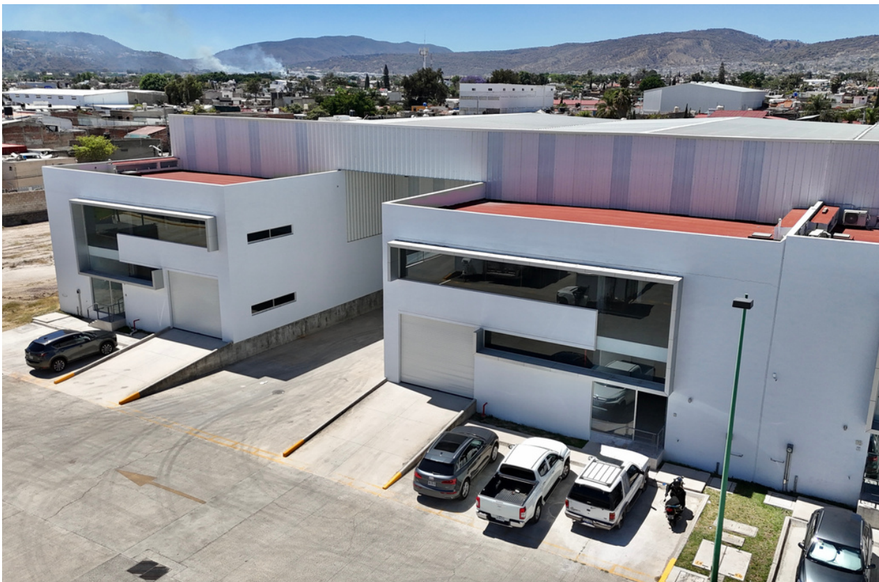
FACHADA DE BODEGAS
