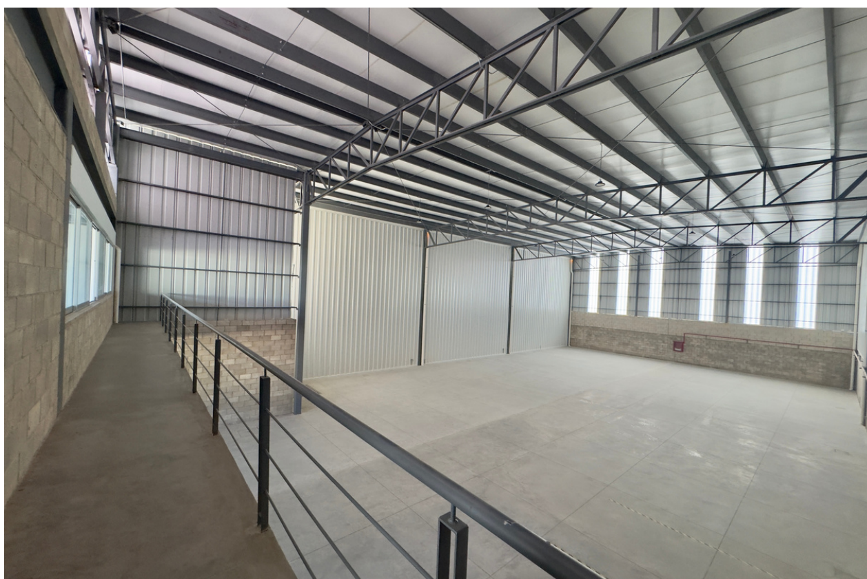
VISTA DE ALMACEN DESDE SEGUNDO PISO
