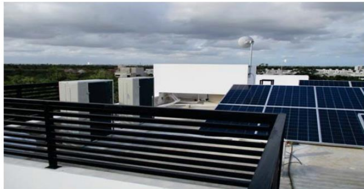
Uso correcto de louver para ocultar paneles solares
