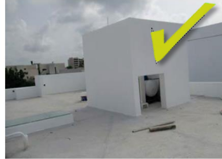
Uso correcto de muretes para ocultar tinaco y tanque estacionario de gas.
