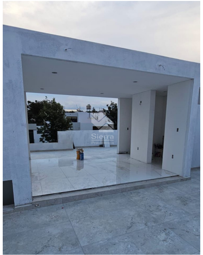
Avance de Obra
