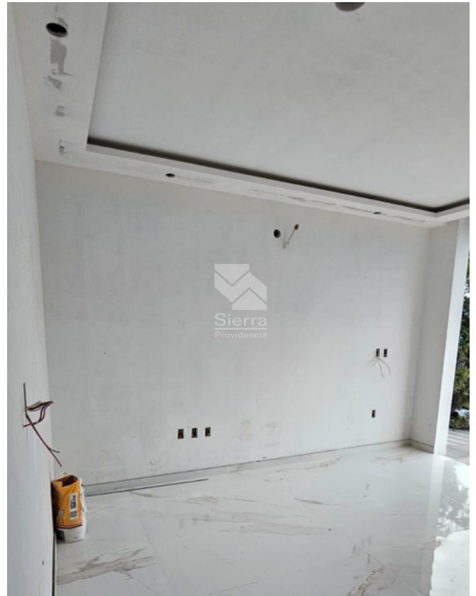
Avance de Obra
