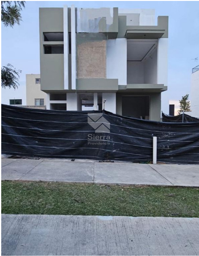
Avance de Obra
