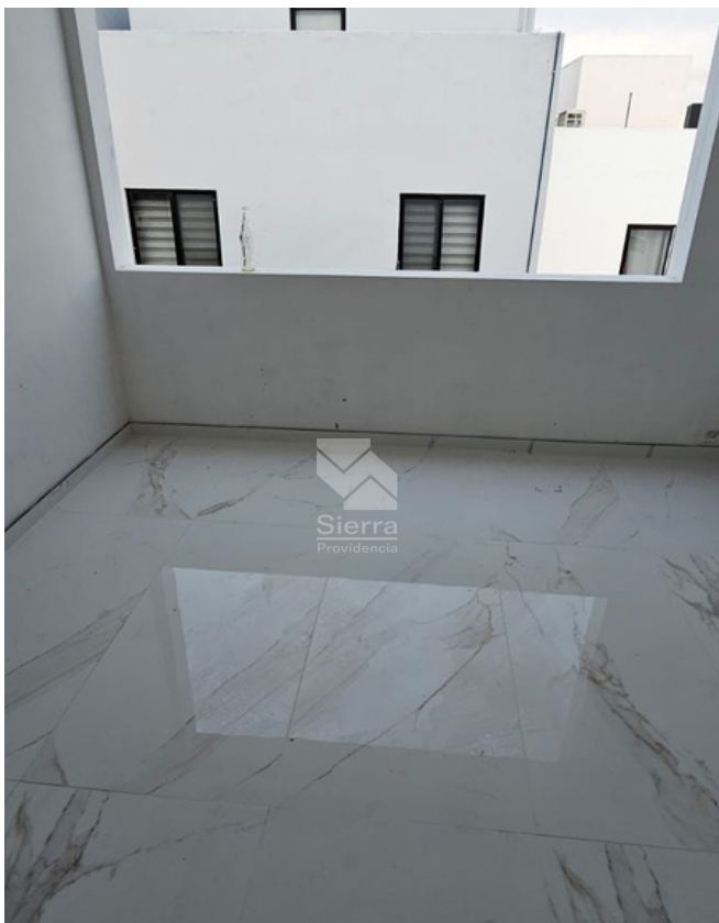
Avance de Obra
