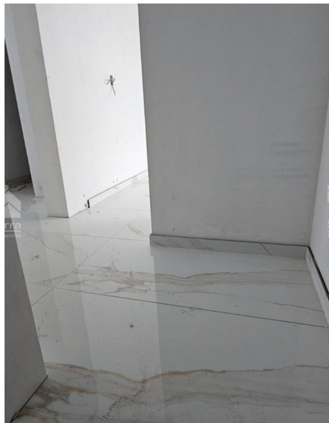
Avance de Obra
