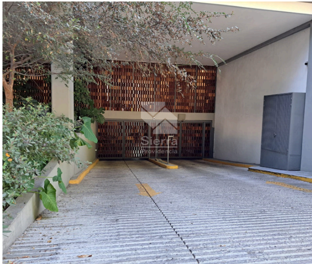
Entrada a estacionamiento
