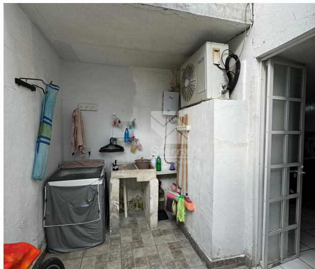
Patio de lavado
