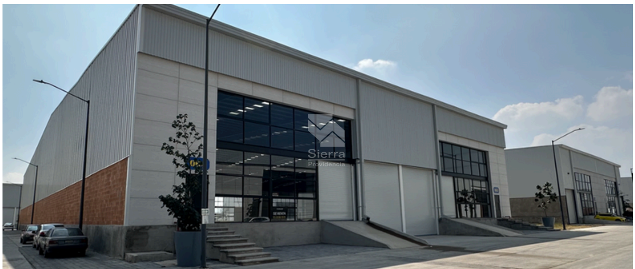
Fachada de bodega
