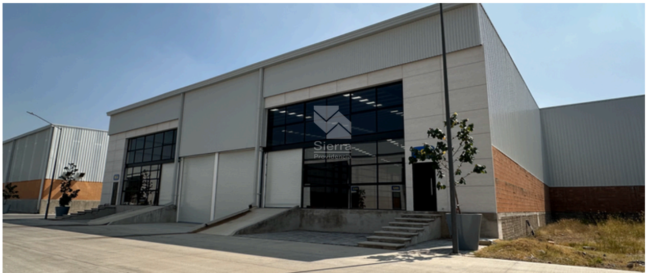
Fachada de bodega
