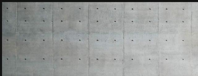
1a. MURO DE CONCRETO APARENTE ACABADO PULIDO, COLADO CON CIMBRA APARENTE DE ALTO RENDIMIENTO.
