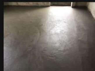
8. LOSA ESTRUCTURAL DE CONCRETO APARENTE ACABADO PULIDO.
