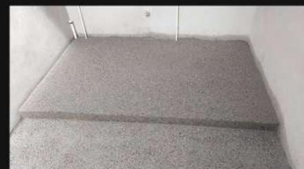
7. FIRME DE CONCRETO APARENTE ACABADO PULIDO, ARMADO CON MALLA ELECTROSOLDADA, SOBRE LOSA DE CONCRETO MACIZA Y/O SISTEMA DE ENTREPISO A BASE DE LOSA MACIZA.
