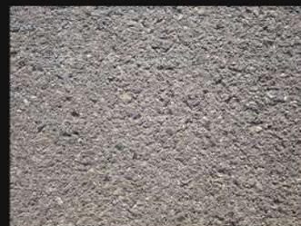
6. FIRME DE CONCRETO LAVADO CON ACABADO DE GRANZON NEGRO, ARMADO CON MALLA ELECTROSOLDADA, SOBRE LOSA DE CONCRETO MACIZA Y/O SISTEMA DE ENTREPISO A BASE DE LOSA MACIZA.
