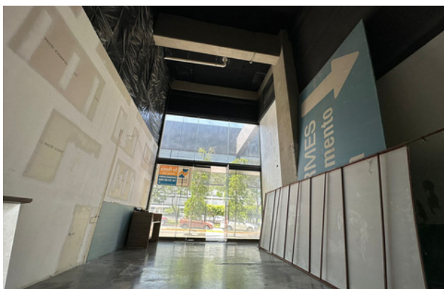
VISTA DE FONDO A INGRESO
