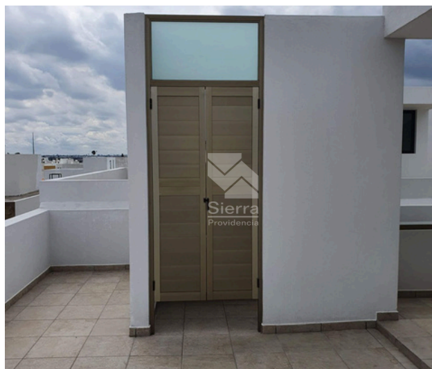
Tinaco e hidro
