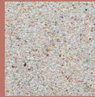
Acabado concreto lavado. (Andadores ext).
