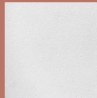
Acabado final en pintura blanca. (Muros lavadero)
