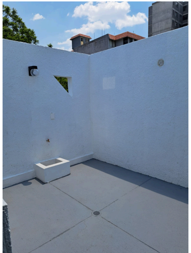
PATIO DE SERVICIO
