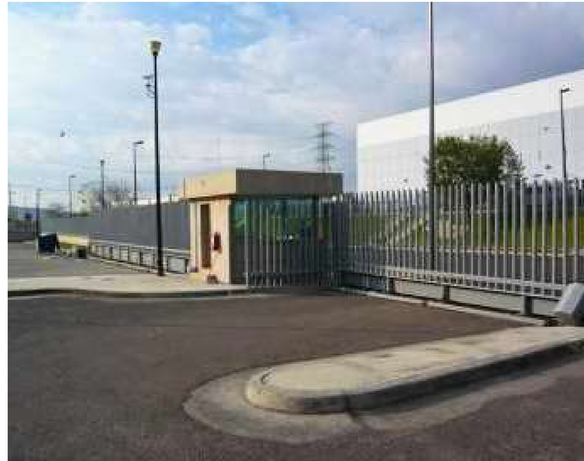
Caseta de seguridad
