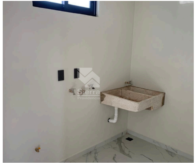
Cuarto de lavado
