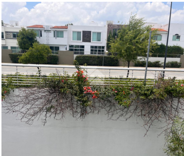
Vista de roof top
