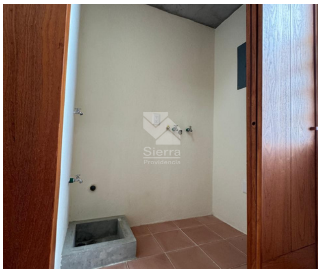
CUARTO DE LAVADO
