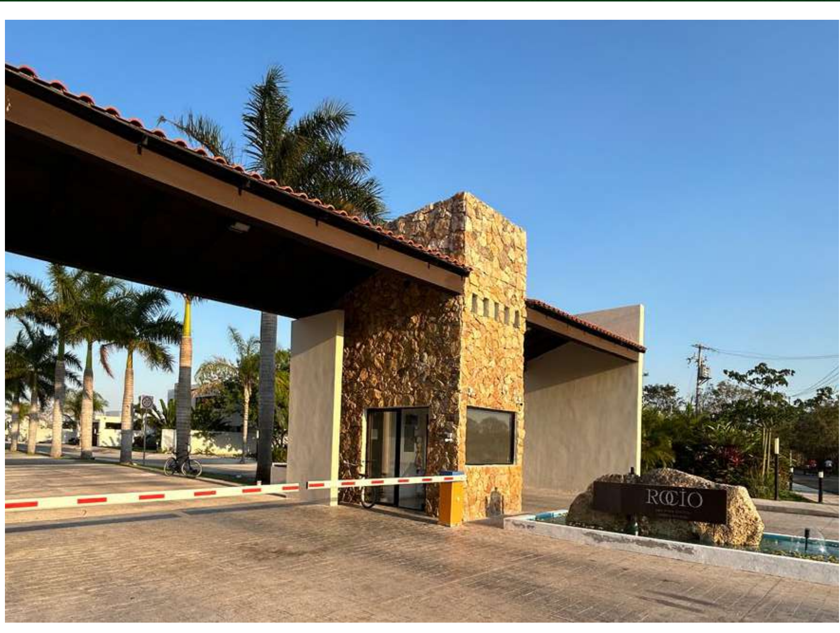
CONTROL DE ACCESO
