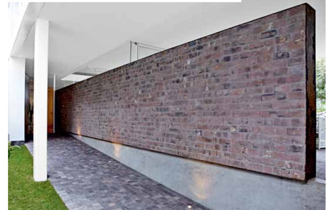
El muro de ladrillos rocosos se convirtió en una pieza arquitectónica cálida e importante. Corre desde el exterior e ingresa a la casa. Está dentro de un marco de hierro de apariencia oxidada. Mide 7 m de largo.
