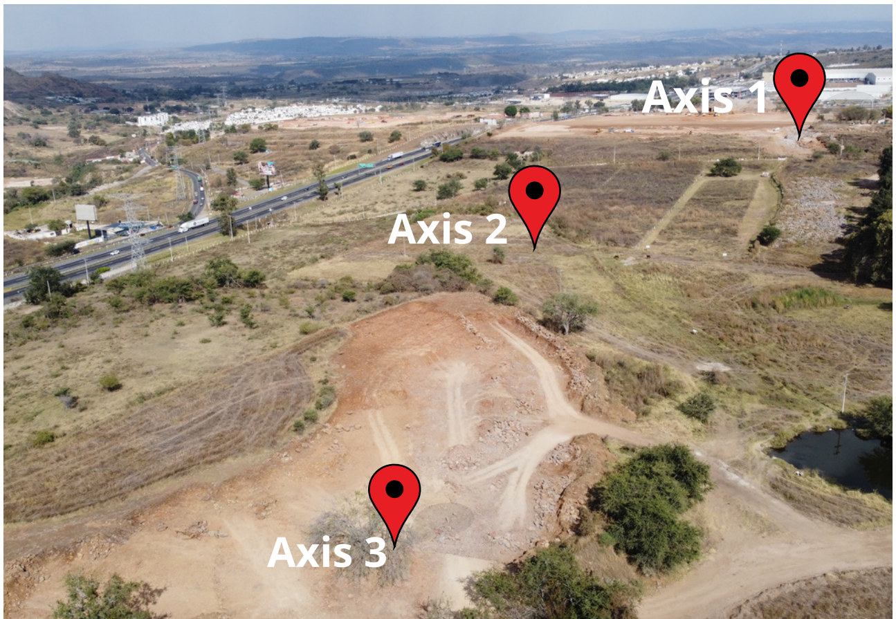
VISTA ÁREA CENTRO LOGISTICO
